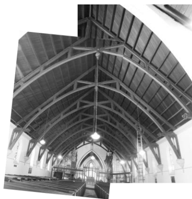
Fig. 4. Imagen de las techumbre interior de la iglesia, construida con vigas compuestas de madera laminada, aplicando de manera vanguardista una técnica de la ingeniería de la época (gentileza del arquitecto Rodrigo Lorca Barros).
